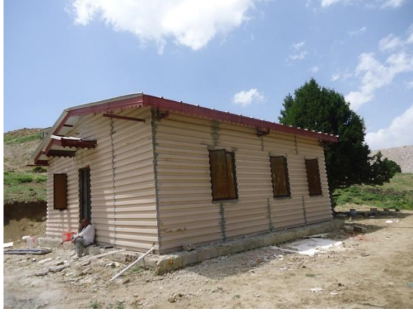
13-Madenli mahallesi 116 ada 3 parsel ( Ramazan YILDIRIM)
