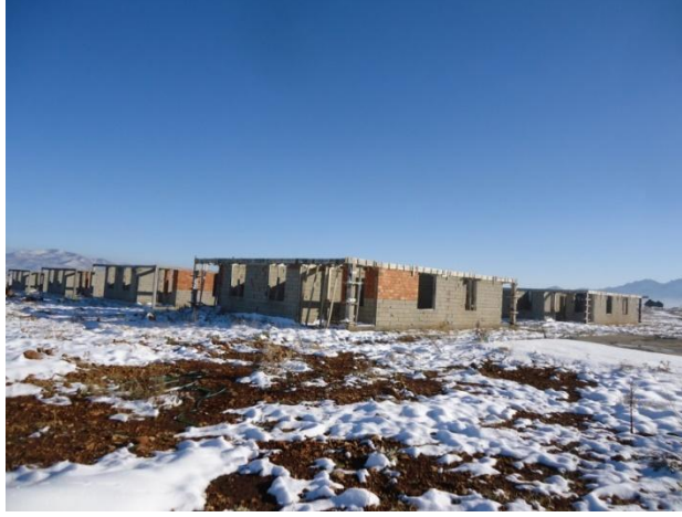
5-ođlakçı mahallesi 120 ada 2 parsel
