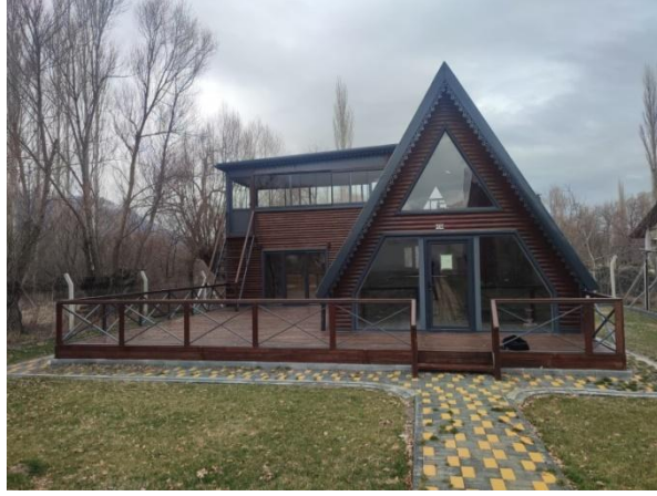
37-Ođlakçı mahallesi 108 ada 4 parsel
