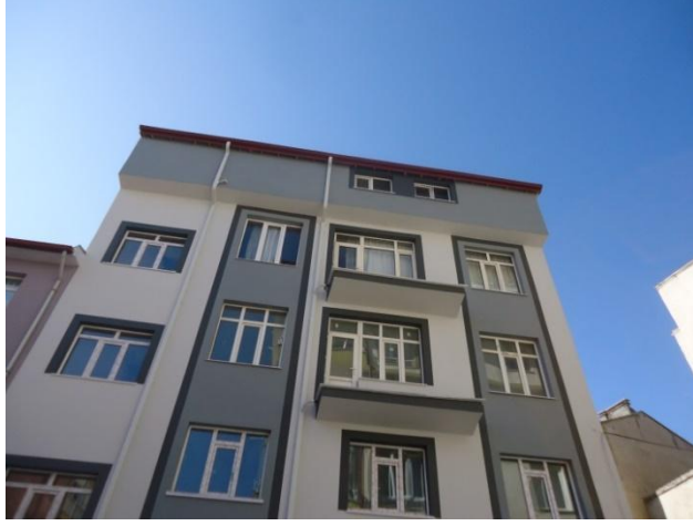
23-Madenli mahallesi 120 ada 1 parsel
