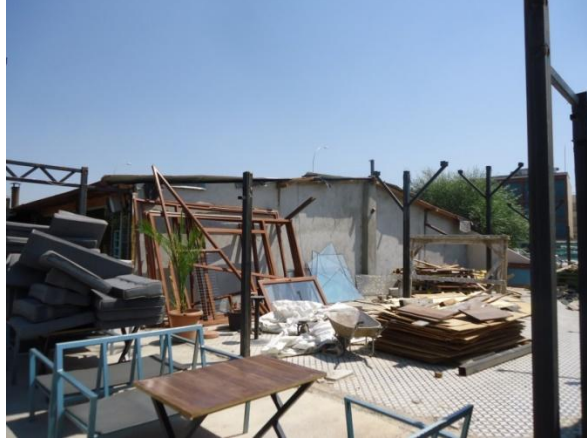
34-Ođlakçı mahallesi 119 ada1 parsel
